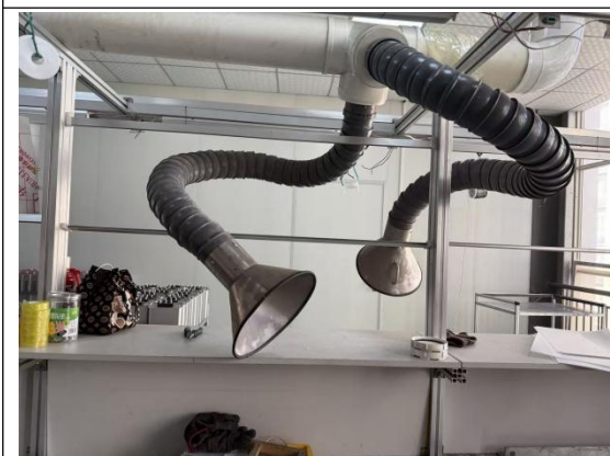
焊接工序废气收集
