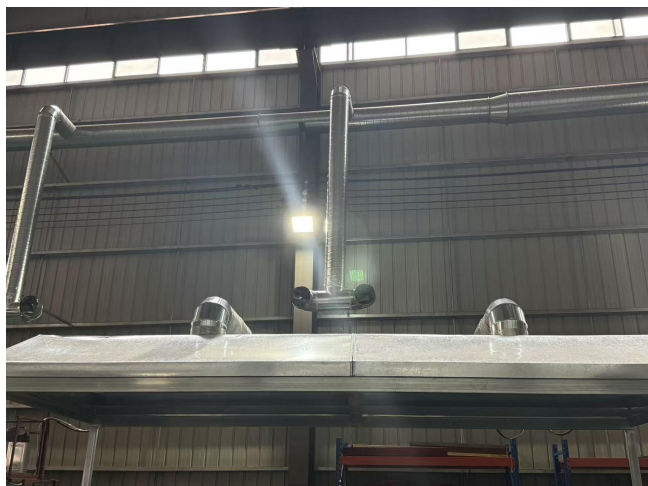
废气集气罩及管道
