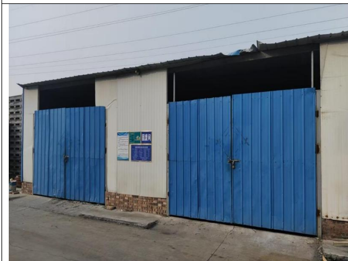
一般固废暂存间
