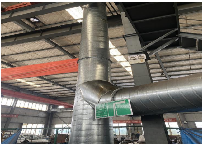
干式过滤+活性炭吸附装置+等离子净化器+15 米高排气筒
