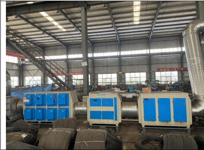
干式过滤+活性炭吸附装置+等离子净化器+15 米高排气筒
